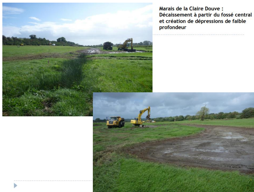
Figure 53 : illustration des travaux menés sur la Claire Douve par le Conservatoire du Littoral (source : Conservatoire du Littoral)
