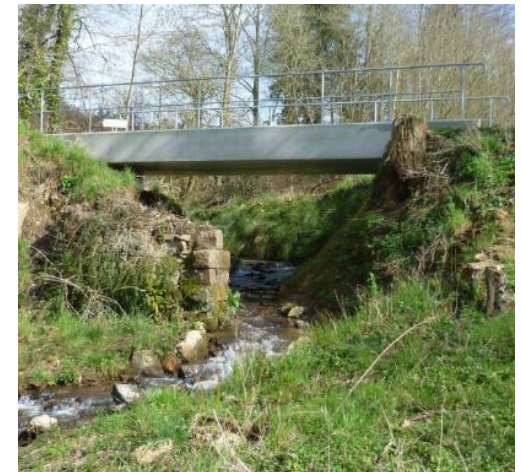
Figure 51 : travaux de rétablissement de la continuité écologique réalisés sur le territoire (source : GTM)
